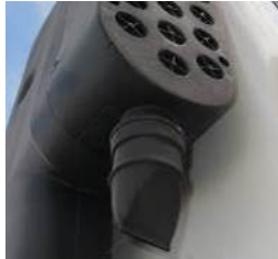
دهانه ورودی قسمت پلاستیکی هواکش
